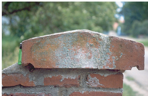
oben: Neu Tornow (Landkreis Märkisch-Oderland), einschaliges Stützmauerwerk aus ganzen und bearbeiteten Natursteinen. mittig: Trebendorf (Landkreis Spree-Neiße), zweischalige Hofmauer aus gespaltenen Findlingen und Ziegelsteinen. unten: Ringenwalde (Landkreis Uckermark), Mauerkrone aus Ziegelformstein als konstruktiver Bautenschutz. Die Ausbildung der seitlichen Tropfnasen verhindert den Regenwasserabfluß über das Mauerwerk. Photos: Pabst, 08.1996.
